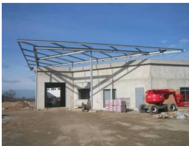
L'entrée, en cours de construction
