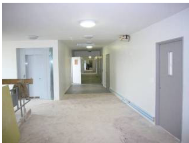
Les couloirs de l'UCSA et du pôle enseignement sont à l'image de couloirs de lycée
